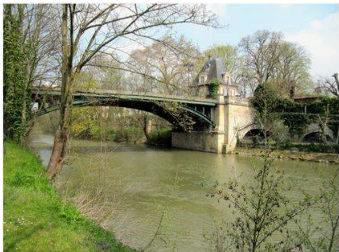
Pont du Moulin
