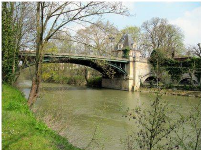
Pont du Moulin
