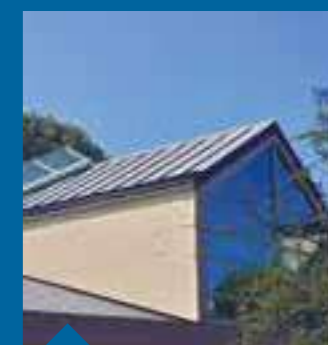
Reprise de la couverture de l'Accueil de loisirs
