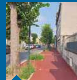
Rénovation des trottoirs de l'avenue des Bonshommes
