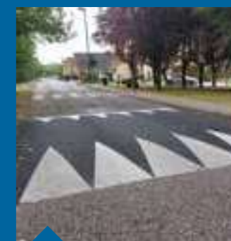
Création de ralentisseurs avenue des Carrières de Cassan
