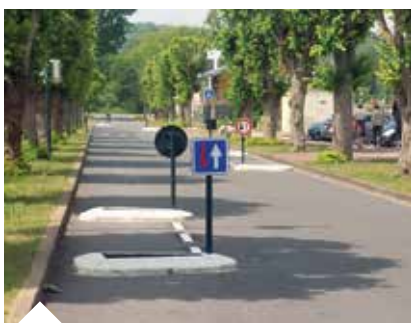
Création de chicanes et de places de stationnement avenue du Chemin vert
