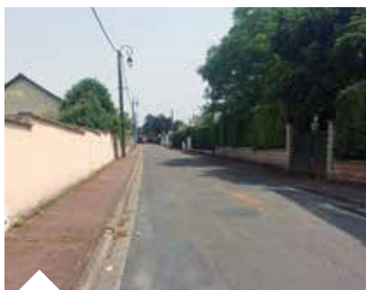
Rénovation de la chaussée rue du Vieux chemin de Paris
